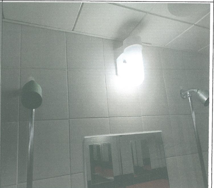
수영장 여자 샤워장 내 벽등 1개소 교체
