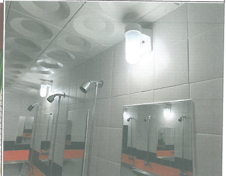
수영장 여자 샤워실 전구 1개소 교체
