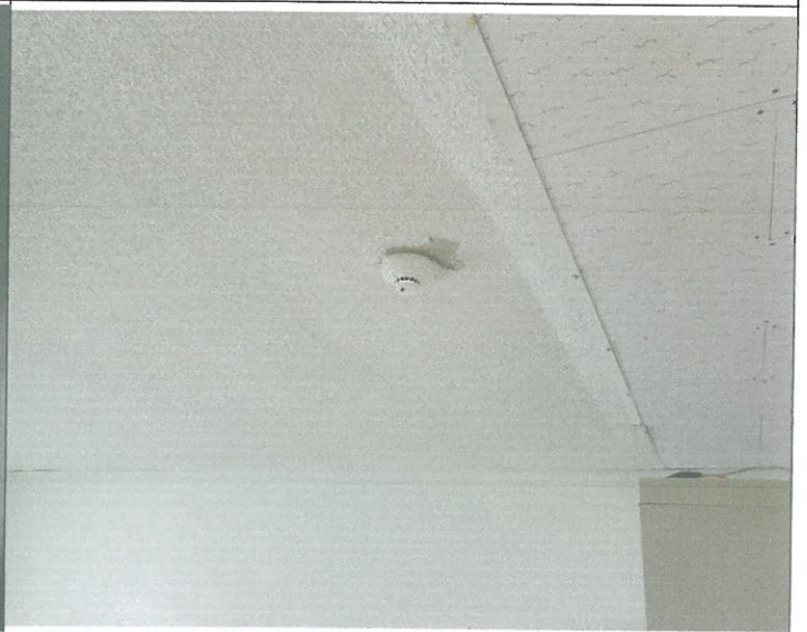
지하1층 수영장 계단 복도 감지기 1개소 교체
