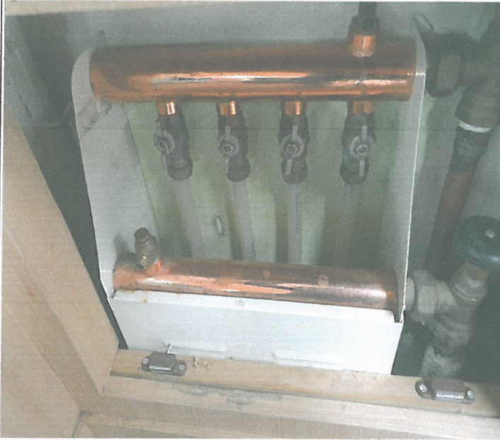
1층 방가후 아카데미 + 유스룸 + 2층 요가 교실 바닥 난방 점검 및 에어처리
