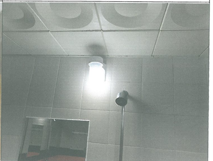
수영장 여자 샤워장 벽 등 1개소 전구 교체
