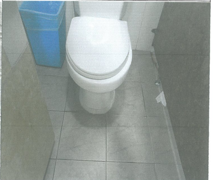
1층 남자 화장실, 2층 남자 화장실 대변기 2개소 매지 시공
