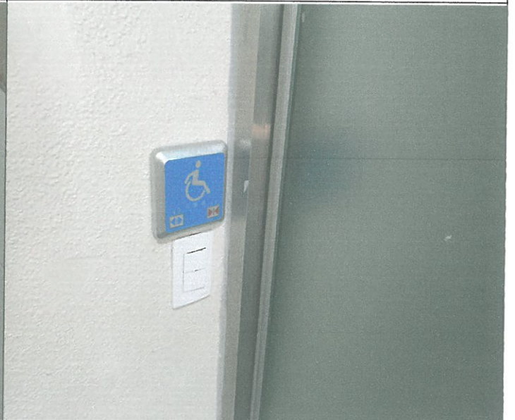
1층 여자 장애인 화장실 자동 출입문 버튼 리모컨 배터리 교체
