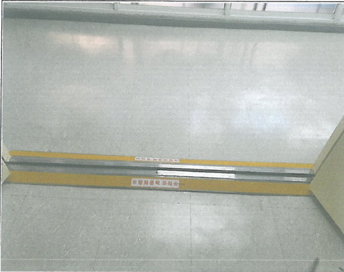
3층 복도 방화문 문턱 실리콘 파킹 설치
