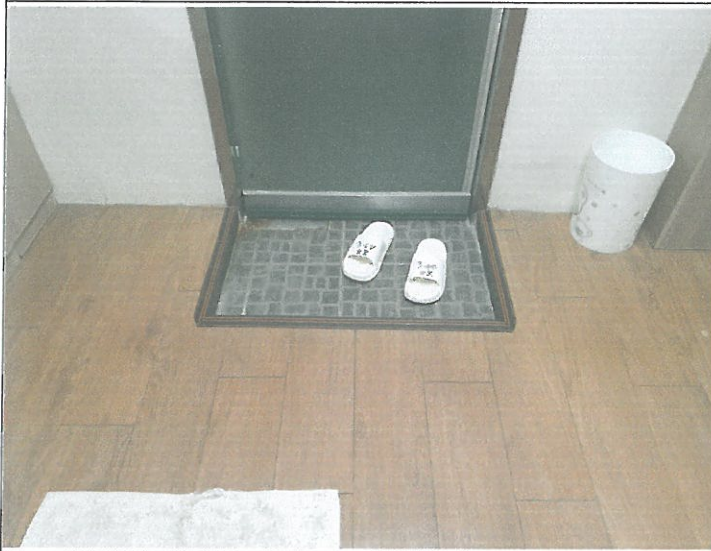
대체육관 남. 여. 샤워실 출입구 마감논슬립 설치작업
