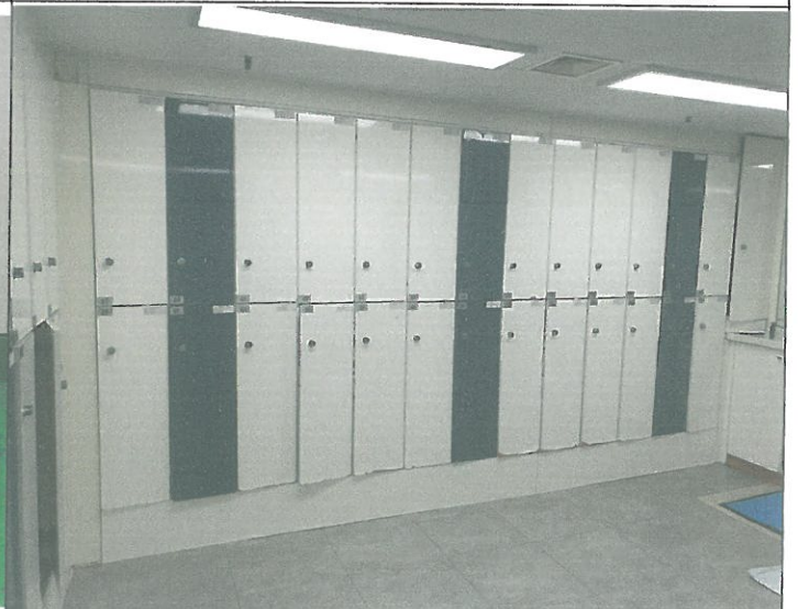
수영장 남자 탈의실 락카 문짝 3기 탈락 수리
