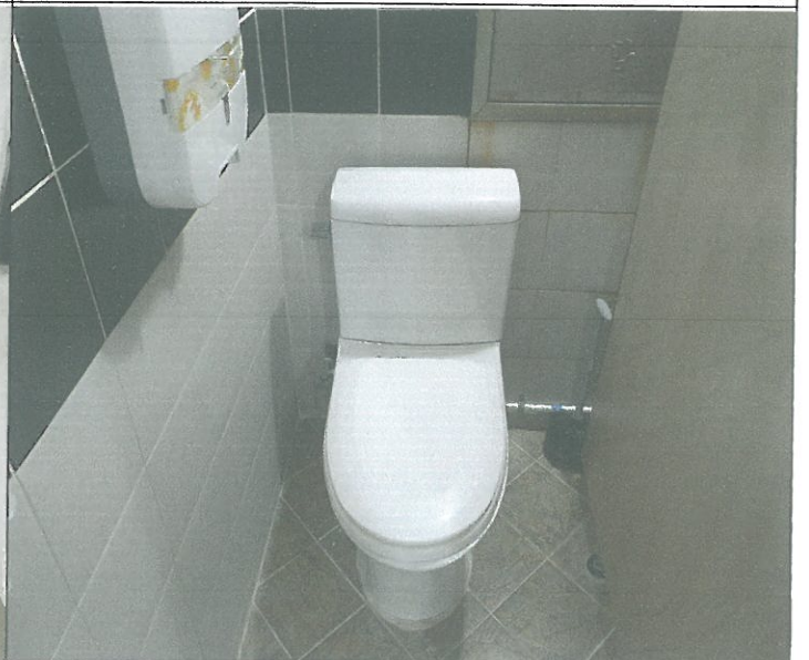
수영장 남자 샤워실 내부 화장실 변기 급수 후렉시블 교체
