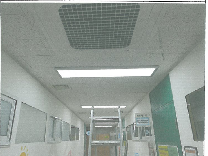
2층 상담복지 센터 복도 천장 매립등 교체
