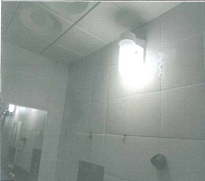
수영장 남자 샤워장 내 벽등 1개소 교체
