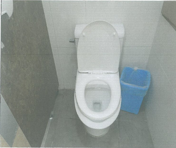
1층 남자 화장실 변기 커버 파손 교체
