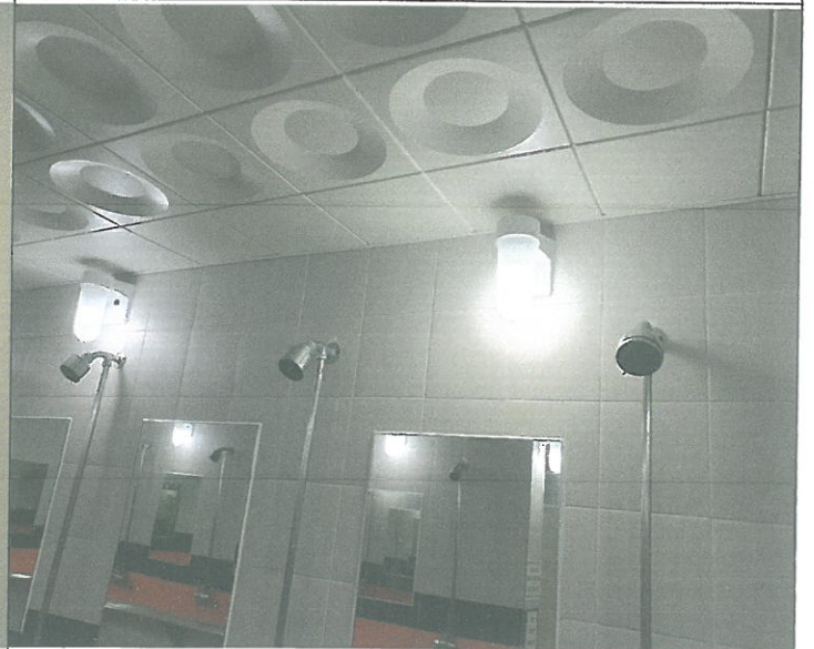
수영장 여자 샤워장 내 벽 등 1개소 전구 교체
